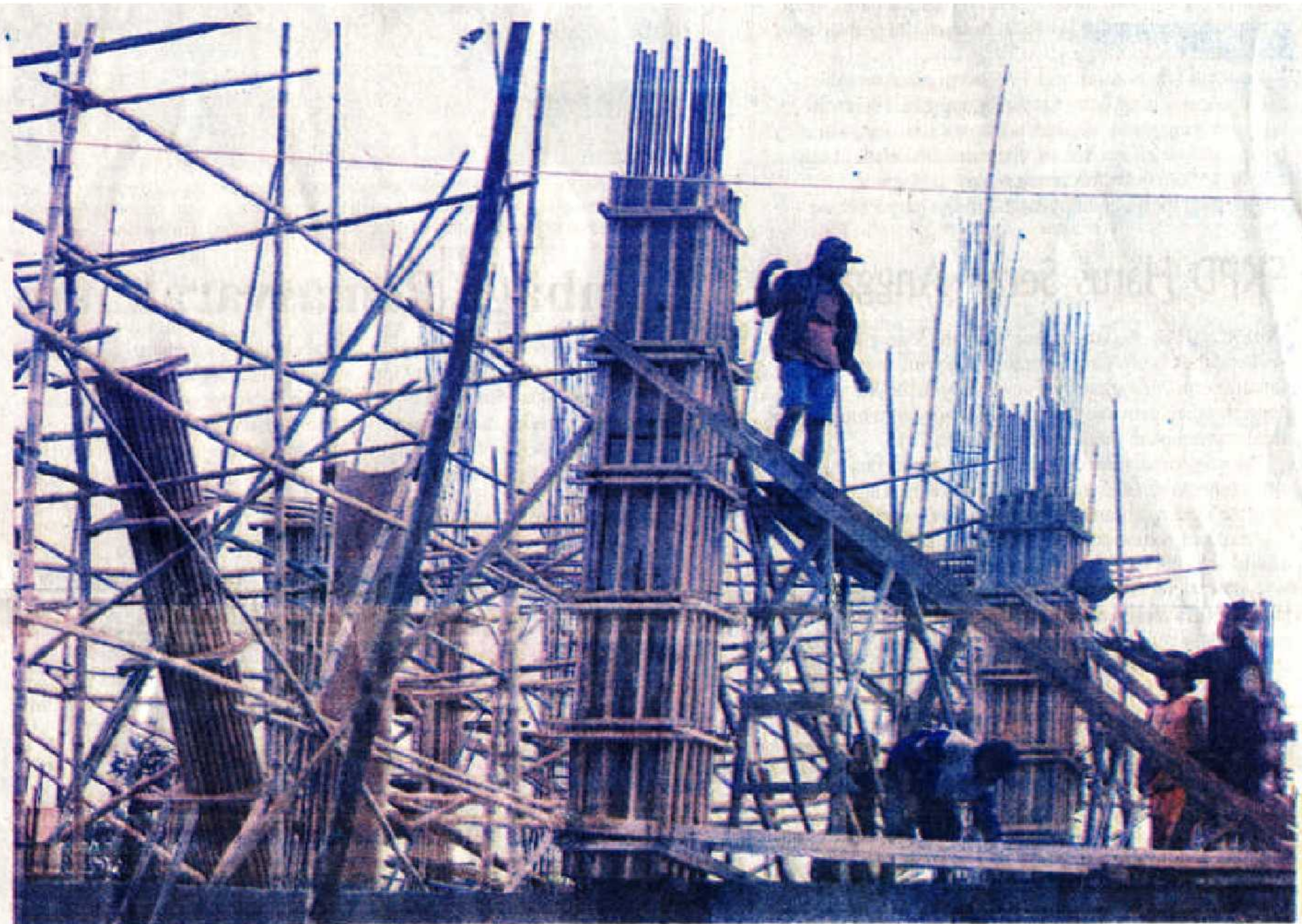
SEJUMLAH pekerja sedang menyelesaikan pembangunan gedung wanita di Jalan Mohammad Yamin, Rabu(23/11). Lanjutan pembangunan gedung tersebut sudah berjalan sekitar dua bulan. FOTO: AMAR SAKTUMS
